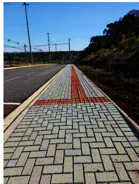
PASSEIO PÚBLICO COM PAVIMENTAÇÃO INTERTRAVADA, COM PODOTÁTIL IMAGEM ILUSTRATIVA
